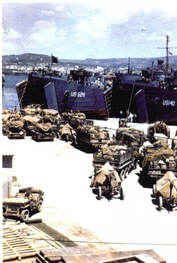
← 德军在撤退之前将那不勒斯的港口设施摧毁殆尽。即便如此，经过盟军人员的辛苦努力，短短数周之内，港口的吞吐能力便得到了一定程度的恢复，大批战备物资开始卸载在港口内。
