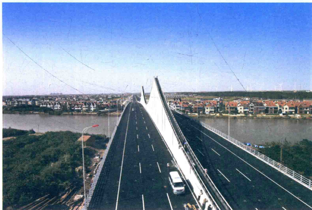
主桥竣工照片(鸟瞰)
