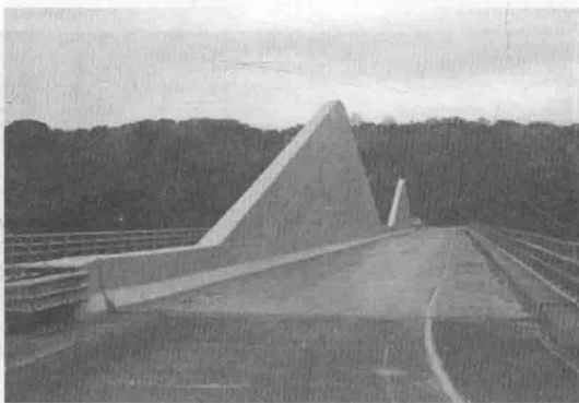
图 1.5 运营中的 Barton Creek Boulevard 桥 (2008 年摄) [3]
