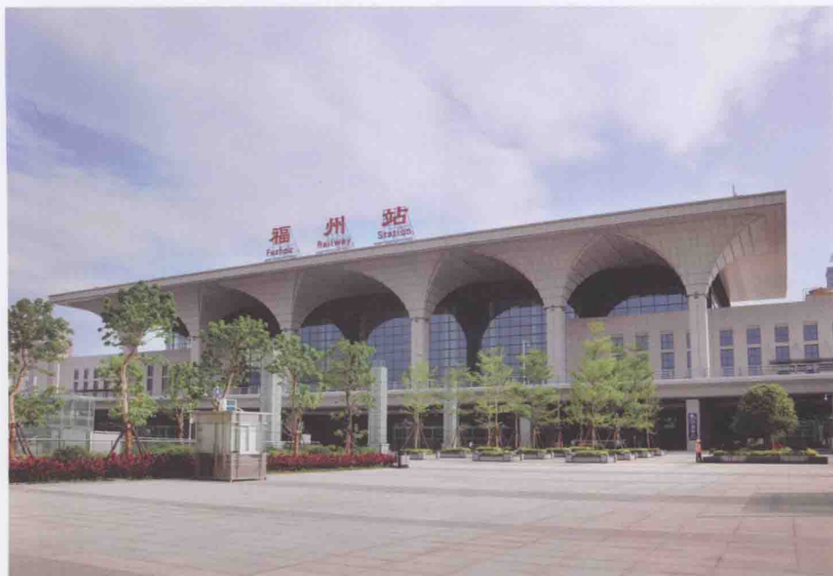
2014年春运投入运营的福州站北站房及广场外景
