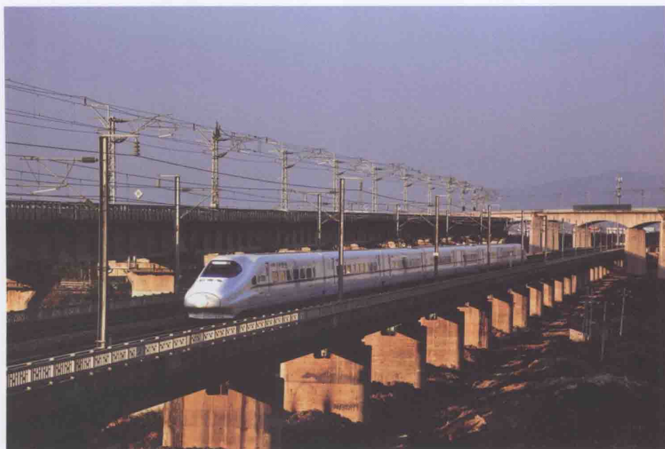
向莆铁路莆田特大桥（高处）与福厦铁路黄石特大桥（动车行驶处）并行
