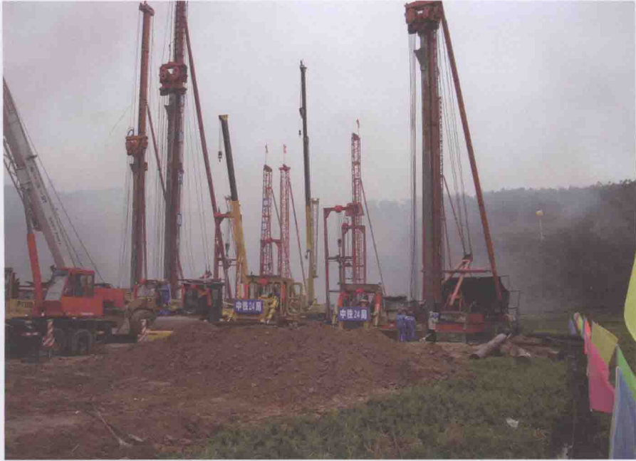
施工机械进入温福铁路开工点
