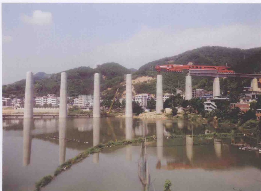
合福铁路客运专线安济特大桥正在铺架
