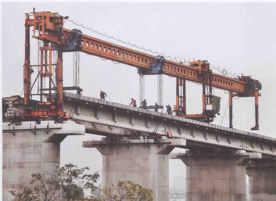
合福铁路客运专线正在架梁施工
