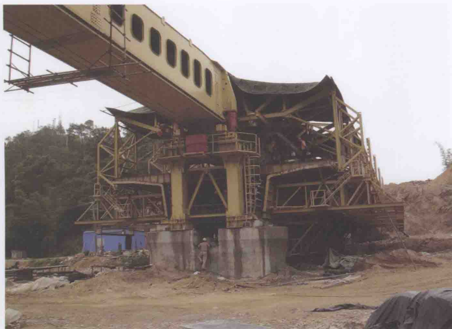
大型制梁机在温福铁路现场浇筑箱梁
