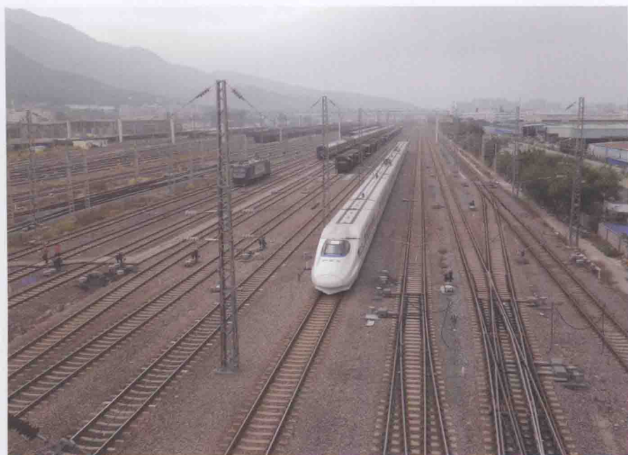
动车组列车驶过樟林站站场
