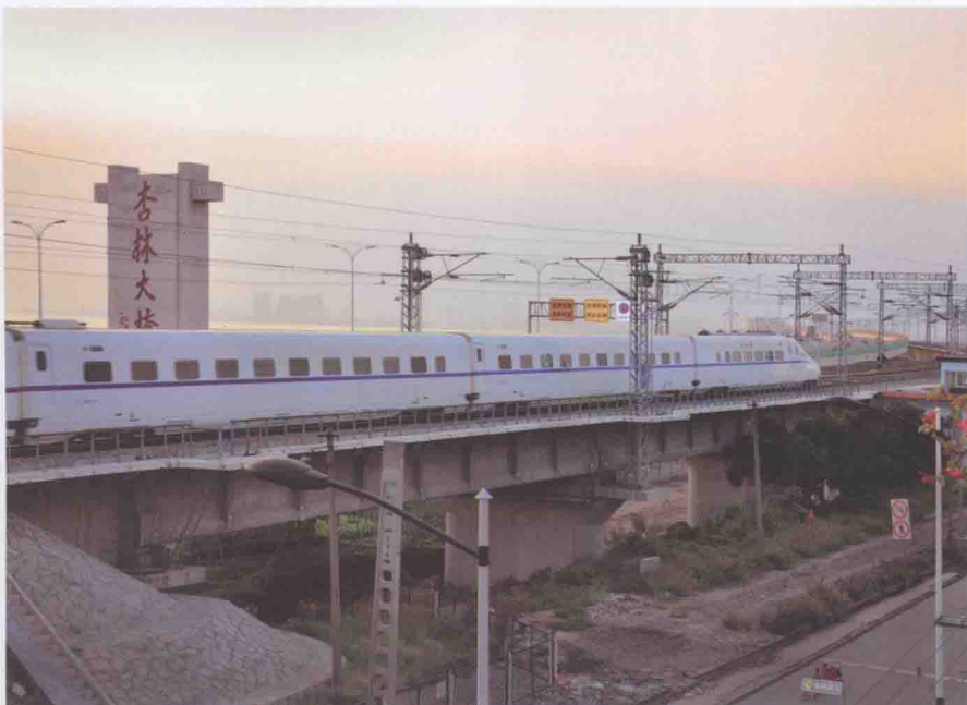
福厦铁路厦门跨海特大桥与杏林跨海公路桥并行
