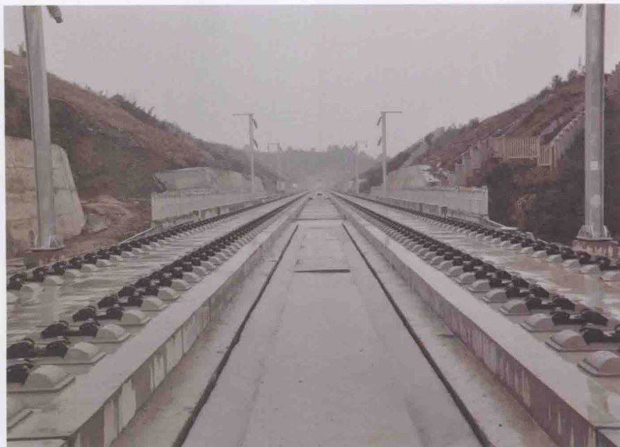
浇筑成形待铺轨的无砟轨道基础
