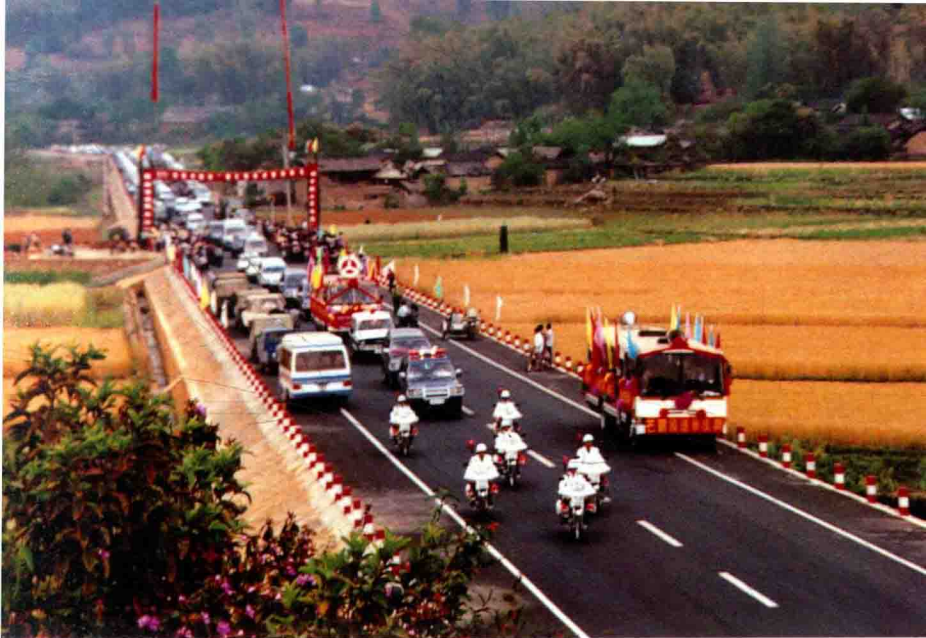
320国道芒瑞段竣工通车
