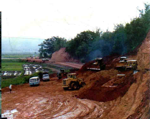
320国道遮放二级公路改建施工
