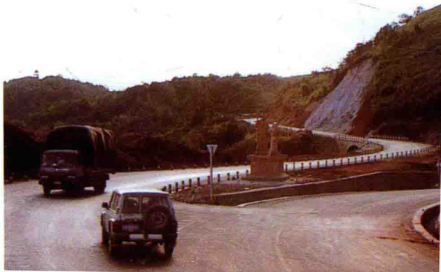
320国道畹町叉道
