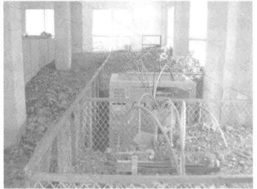
图 1-4 电气化设备被泥石流掩埋
