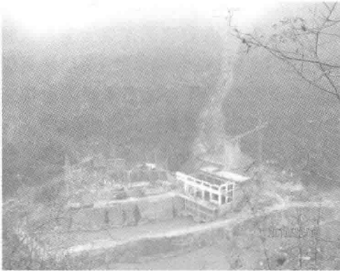
图 1-3 厂房泥石流破坏
