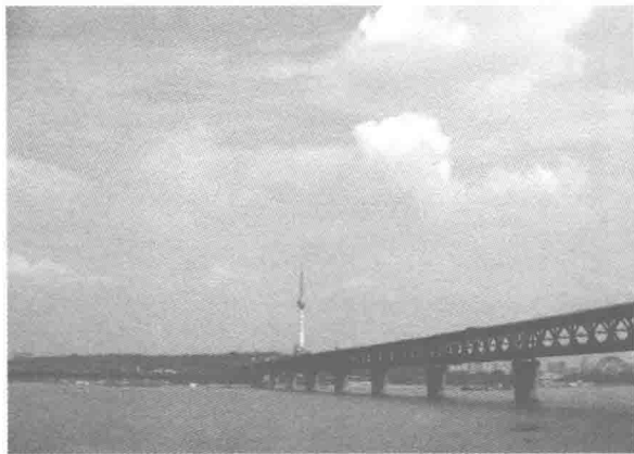
武汉 长江大桥
