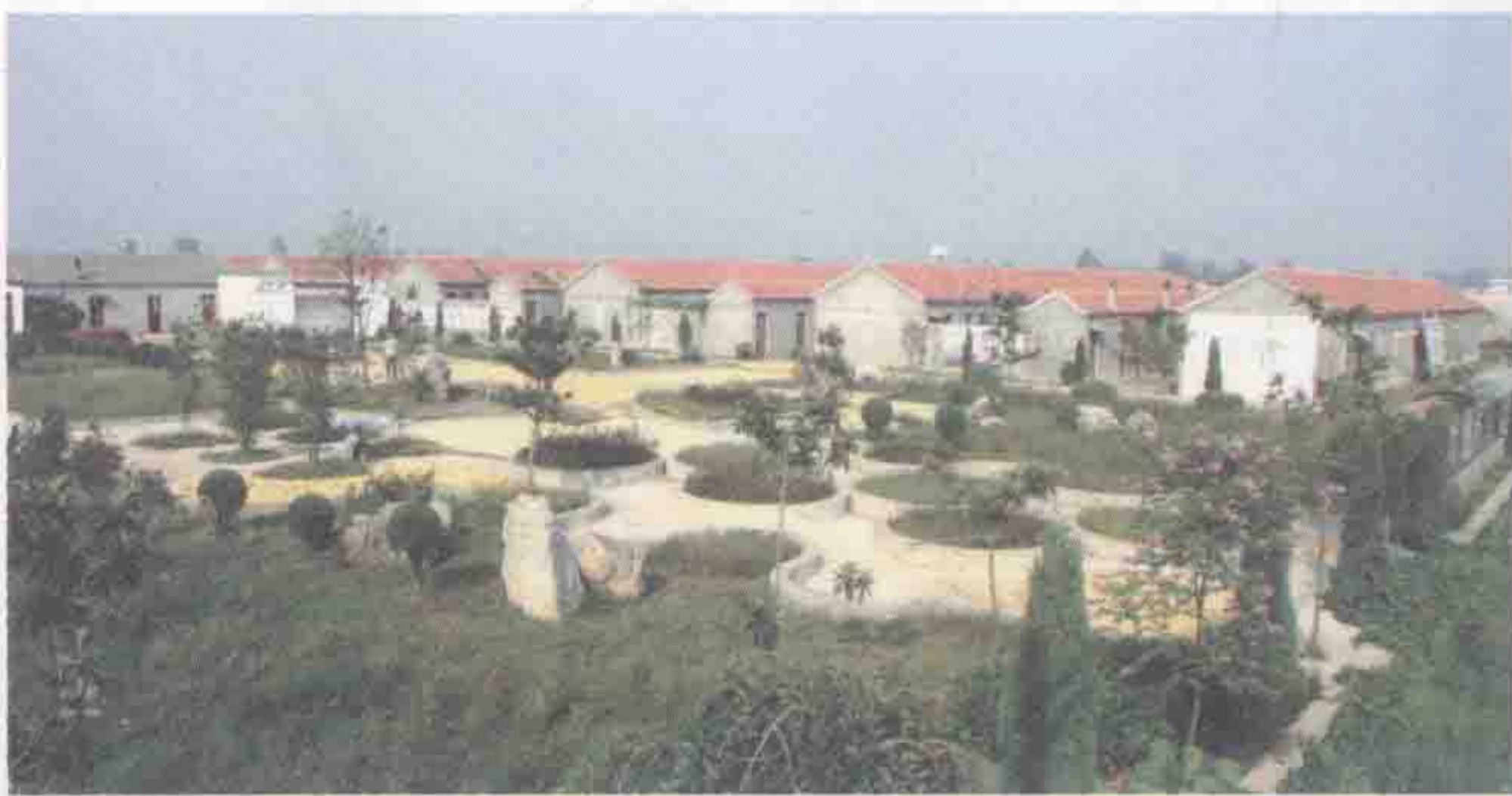
王家坝保庄圩安置区
