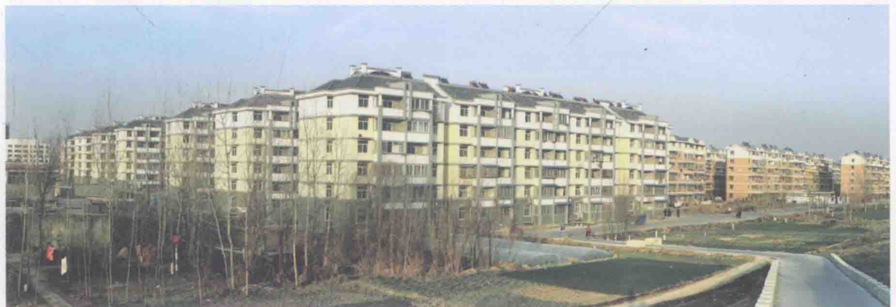
淮河滩区涡河口居民迁建安置区
