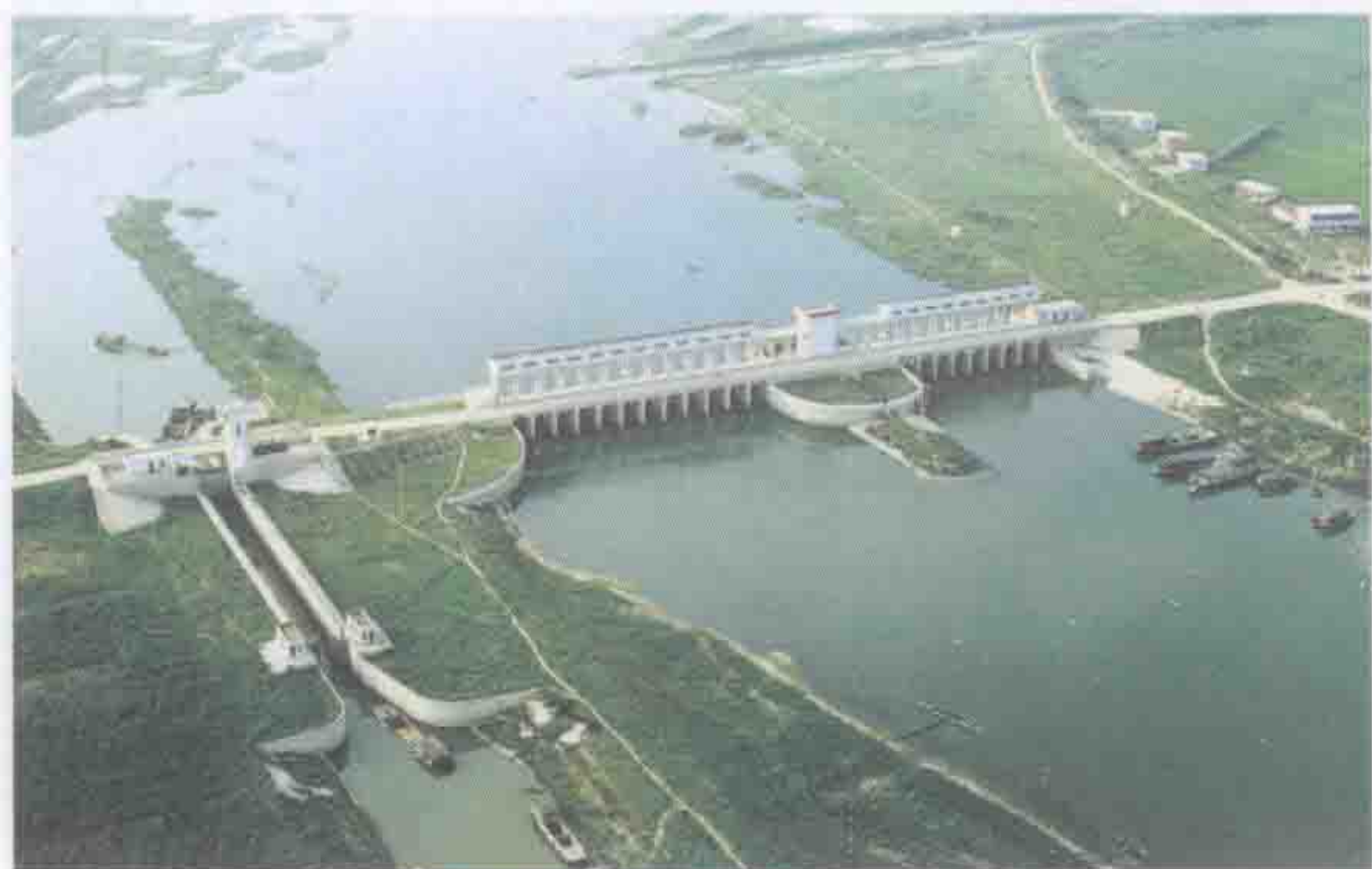
包汾河固镇闸
