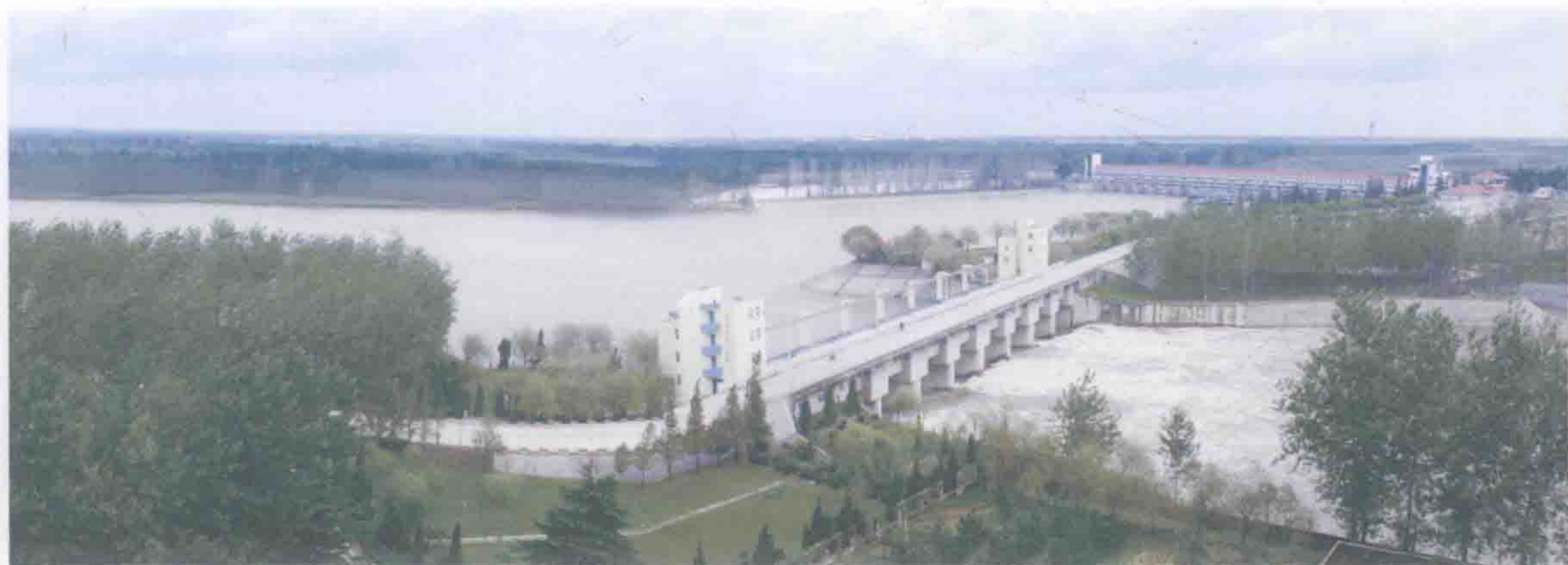
东调南下大官庄水利枢纽
