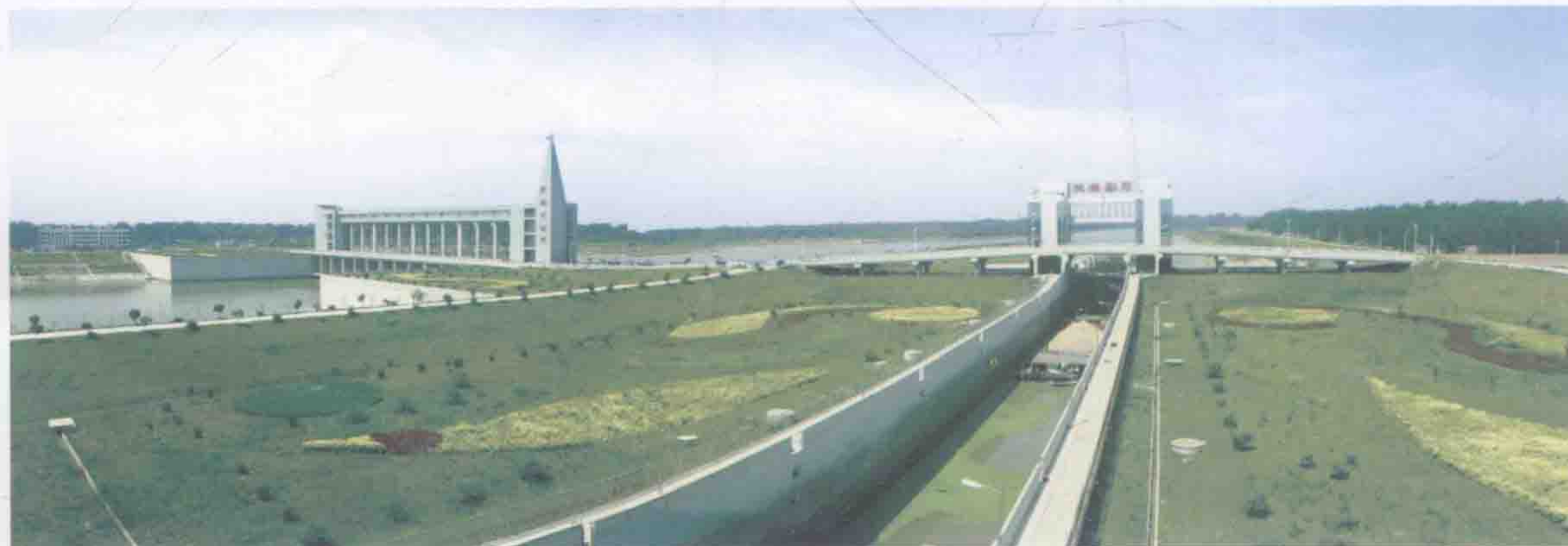
沙颍河耿楼枢纽
