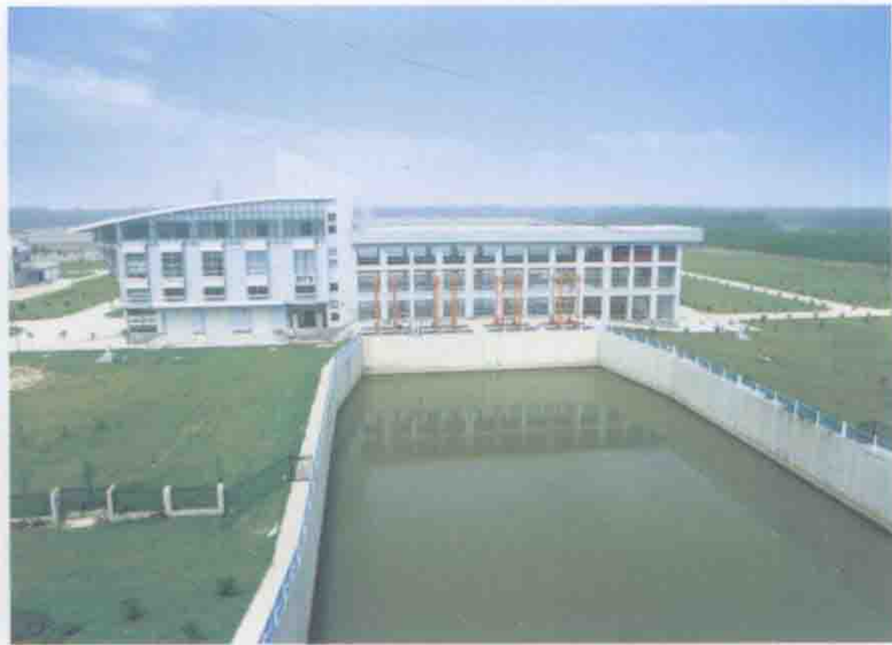
南水北调高家坝泵站
