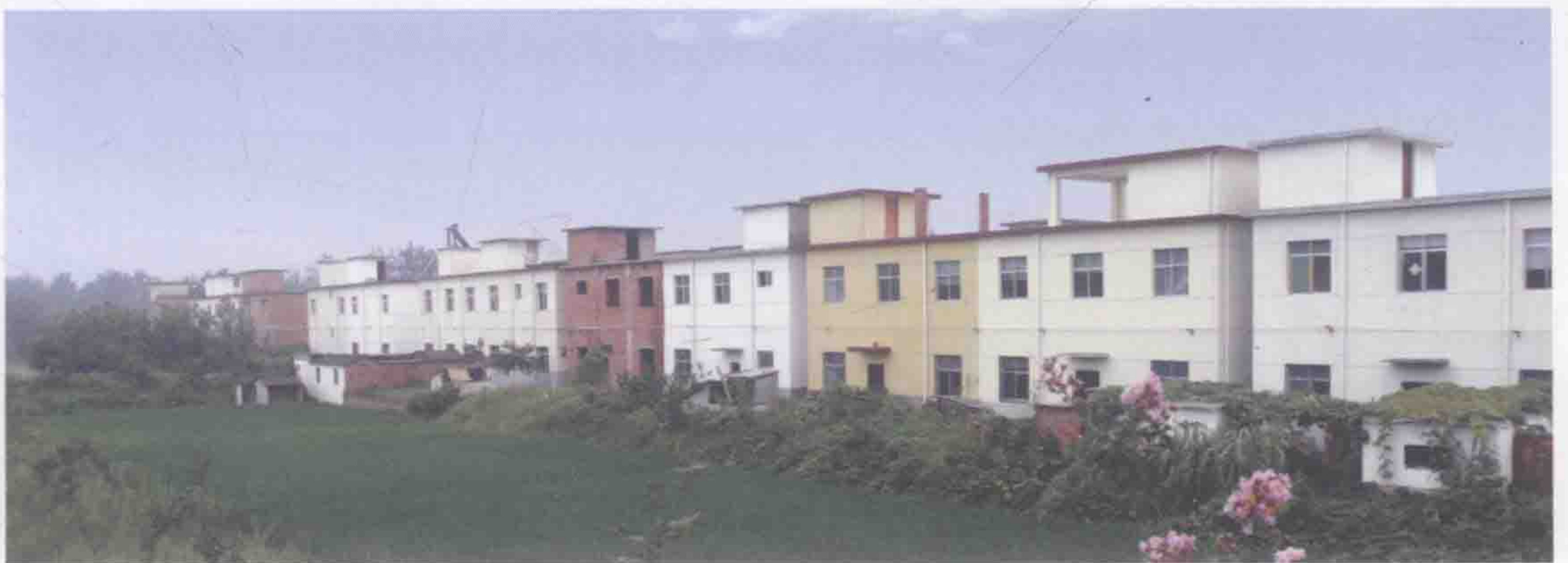
2007 年大水，由于实施了行蓄洪区和滩区居民迁建工程，大部分群众有了安全的固定住所，生活无忧，安定有序
