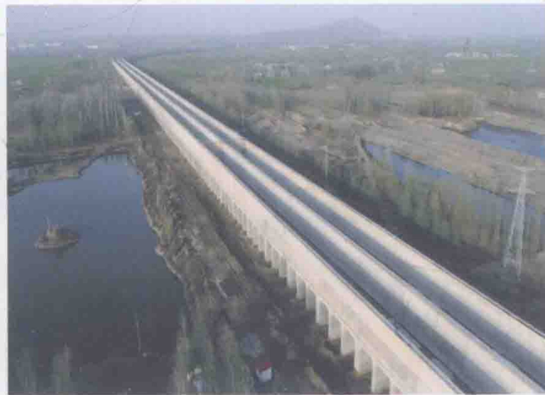
南水北调中线沙河渡槽
