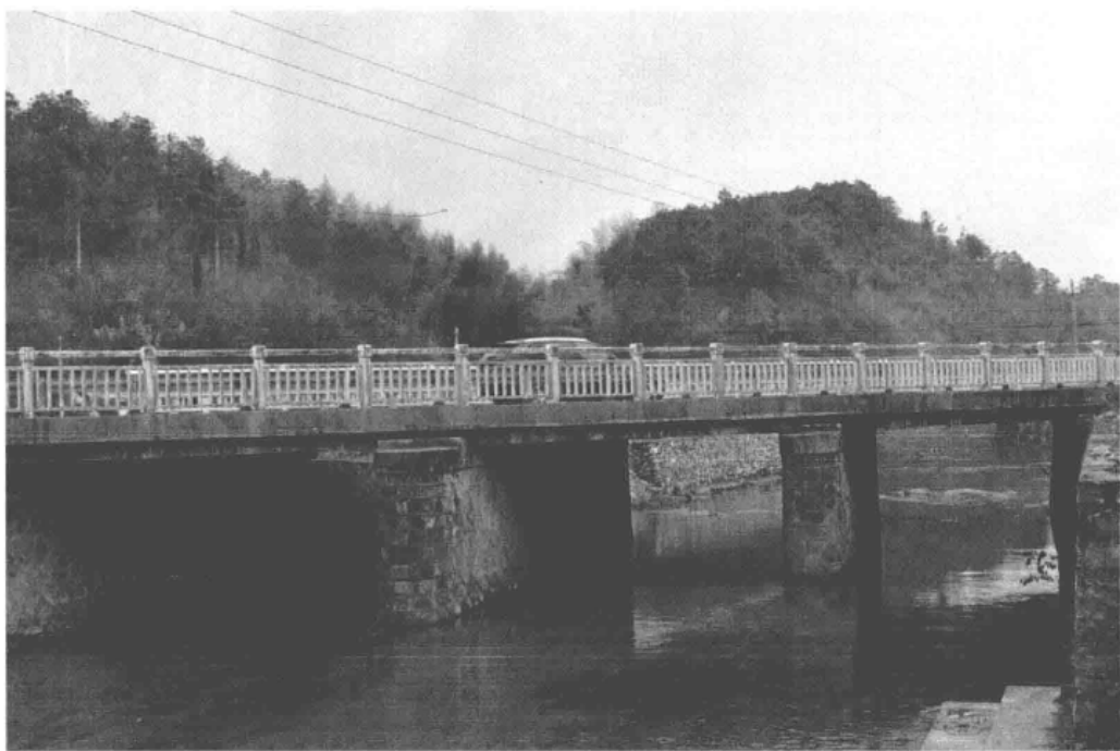
◎ 大桥村公路桥（2013）
