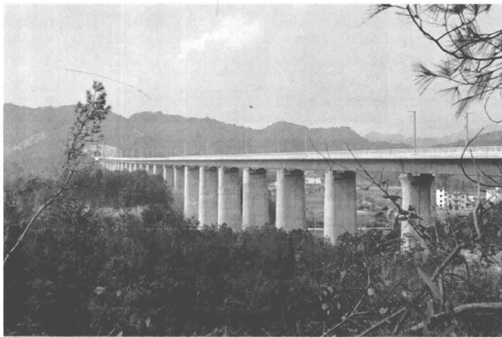
◎ 杭长高铁大桥镇黄石段（2013）
