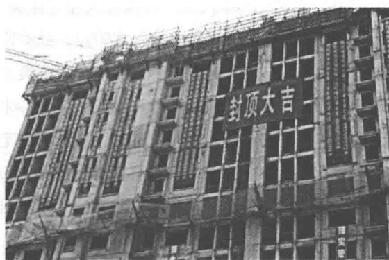
(b) 宇辉滨湖桂园安置房(钢筋浆锚搭接连接)
