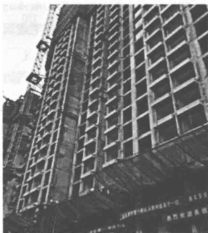
(c) 中南世纪城工程(波纹管浆锚搭接连接)
