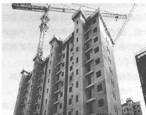
(a) 京投万科新里程(钢筋套筒灌浆连接)
