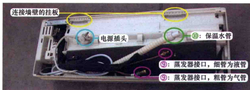
图 1-12 室内机背面外部结构
