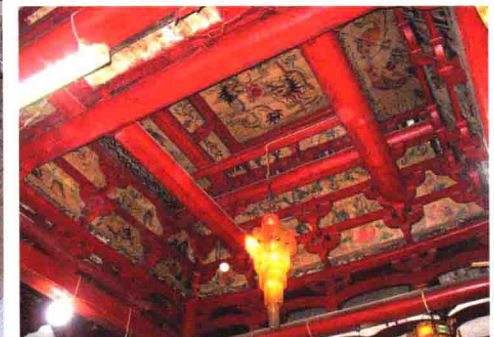
图8 (明)罗源凤山天后宫屋架结构
