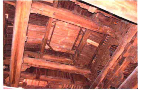
图3 (宋)罗源陈太尉宫大殿屋架结构
