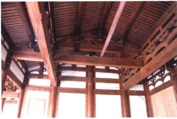
图 15 (清) 三坊七巷郭柏荫故居梁造做法
