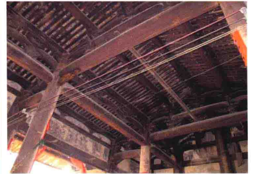
图6 (明)连江厦园里屋架结构
