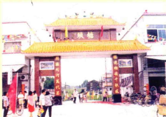
图为陈景鹏、阮肖娟伉俪捐建的六项工程之一塘头门楼。
