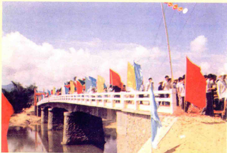
新建成的塘底大桥雄姿
