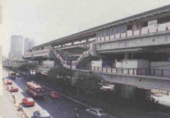
BTS高架车站。
