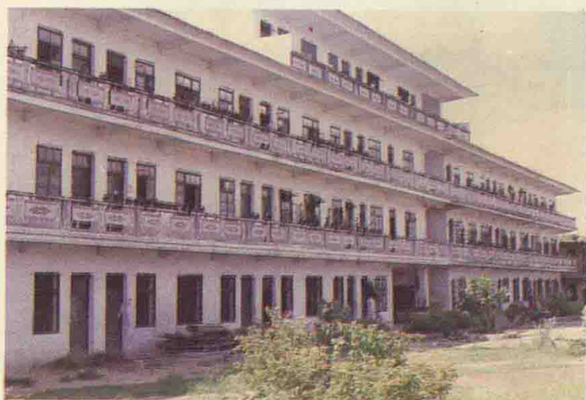
新桥初中教学大楼
