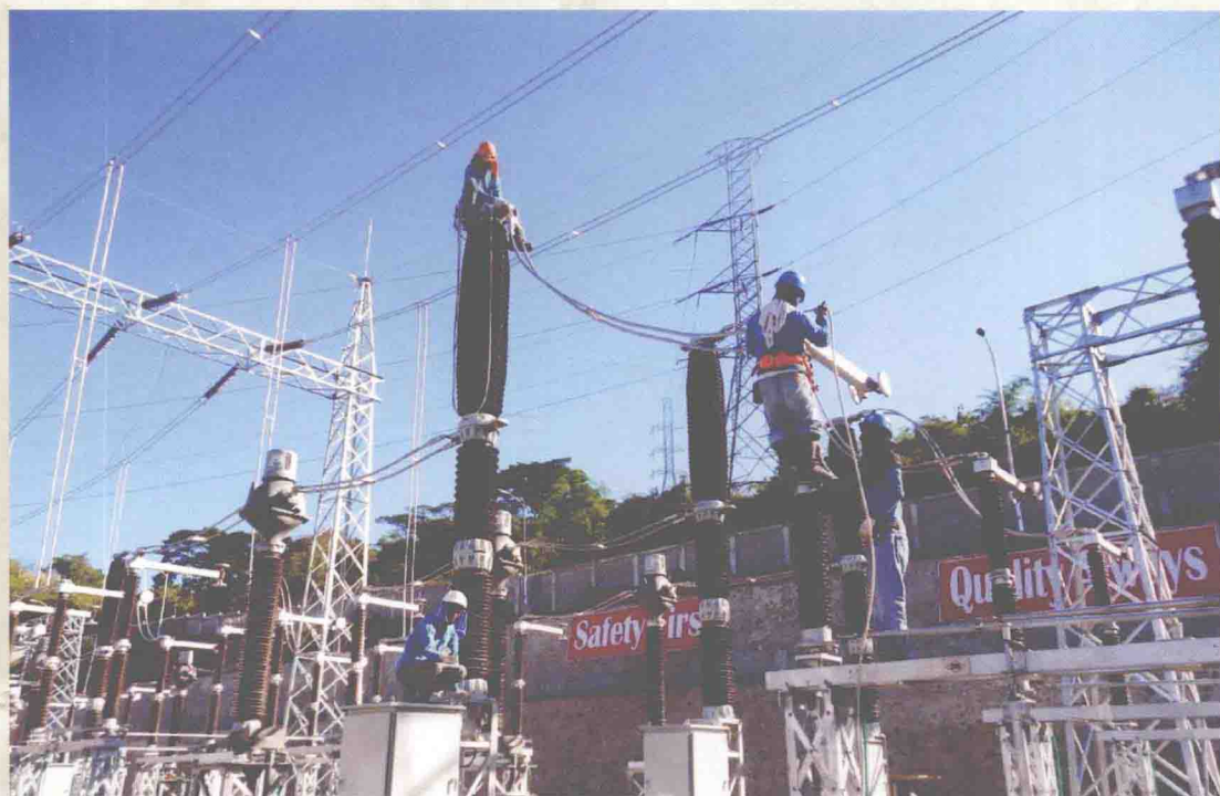
2014年1月24日，山东电电气集团有限公司总承包的菲律宾230kV圣·埃斯特变电站项目一期工程投运。图为工程施工现场。
