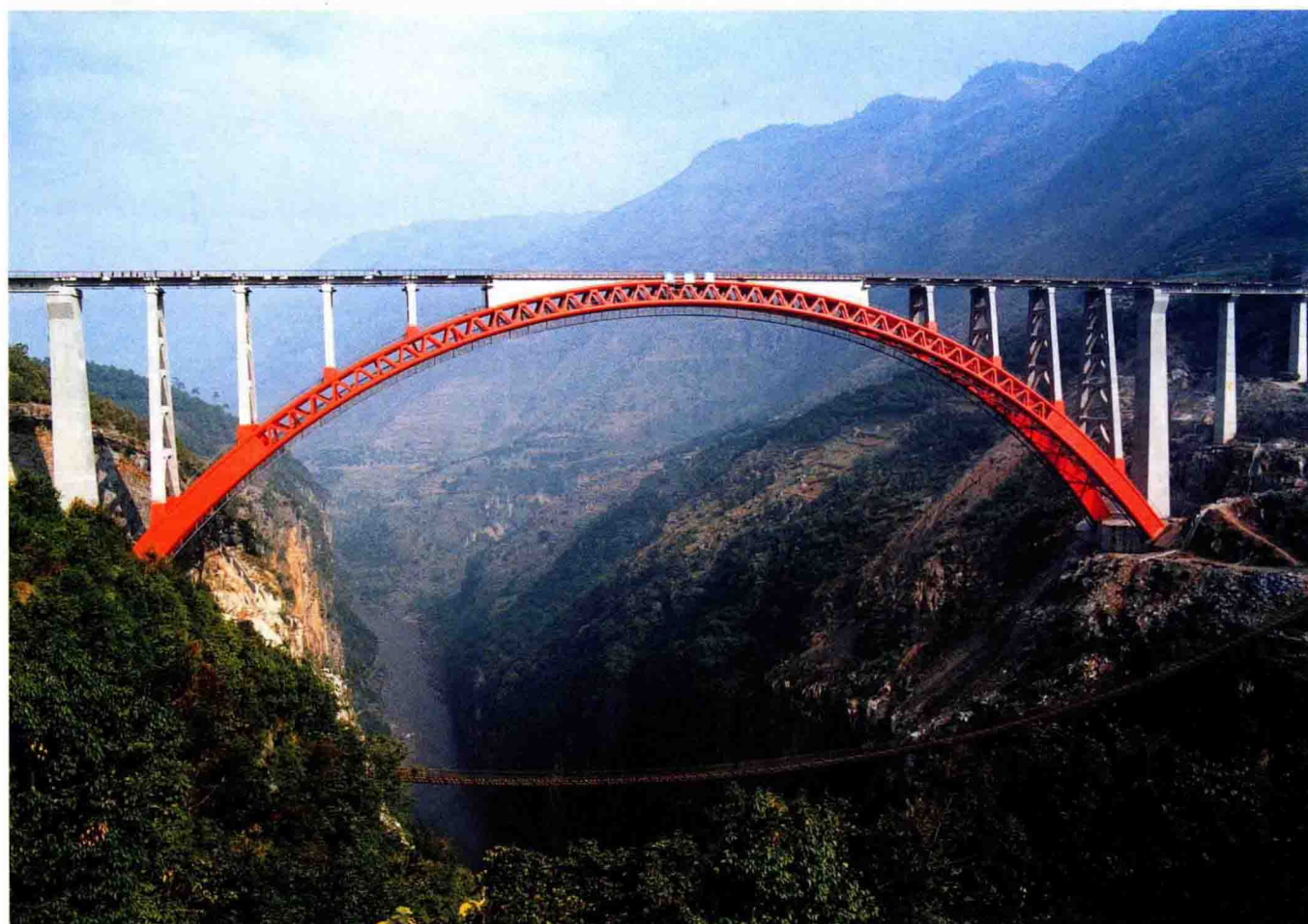
北盘江大桥是我国第一座钢管混凝土拱桥
