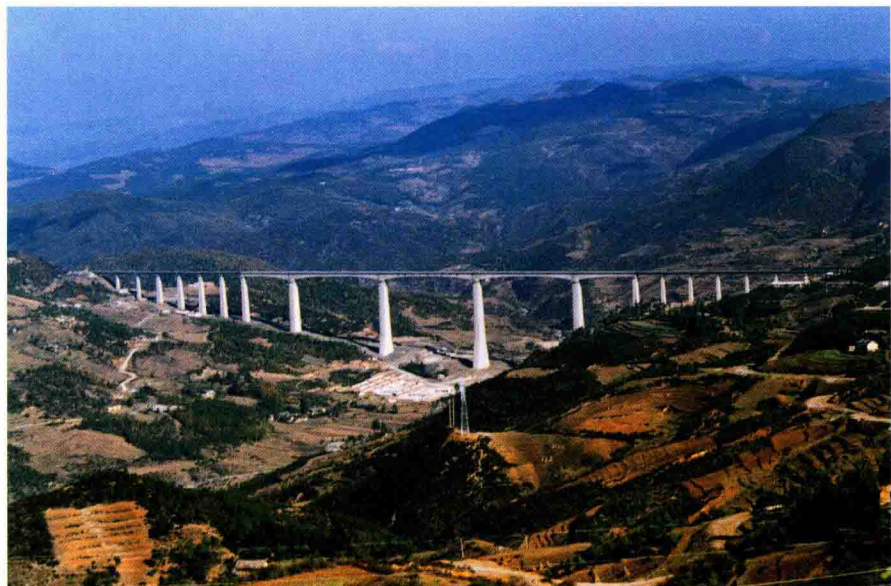
李子沟特大桥
