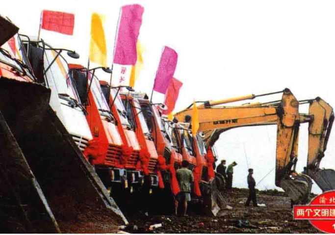
▼ 进场的部分施工设备
