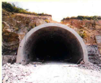
↑ 广东省西部沿海高速公路蛇仔垜隧道
