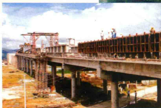
↑ 正在兴建中的镇海湾大桥
