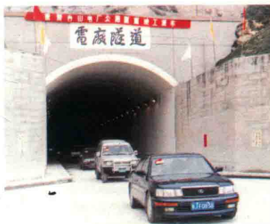
↑ 台山电厂公路隧道竣工通车。
