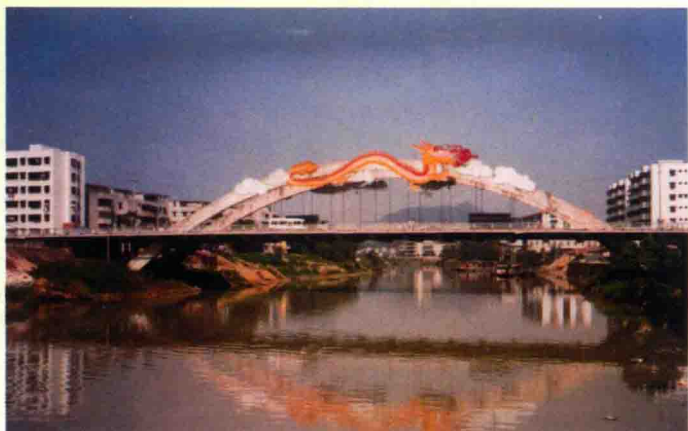
→ 台城过境公路新宁大桥全貌
