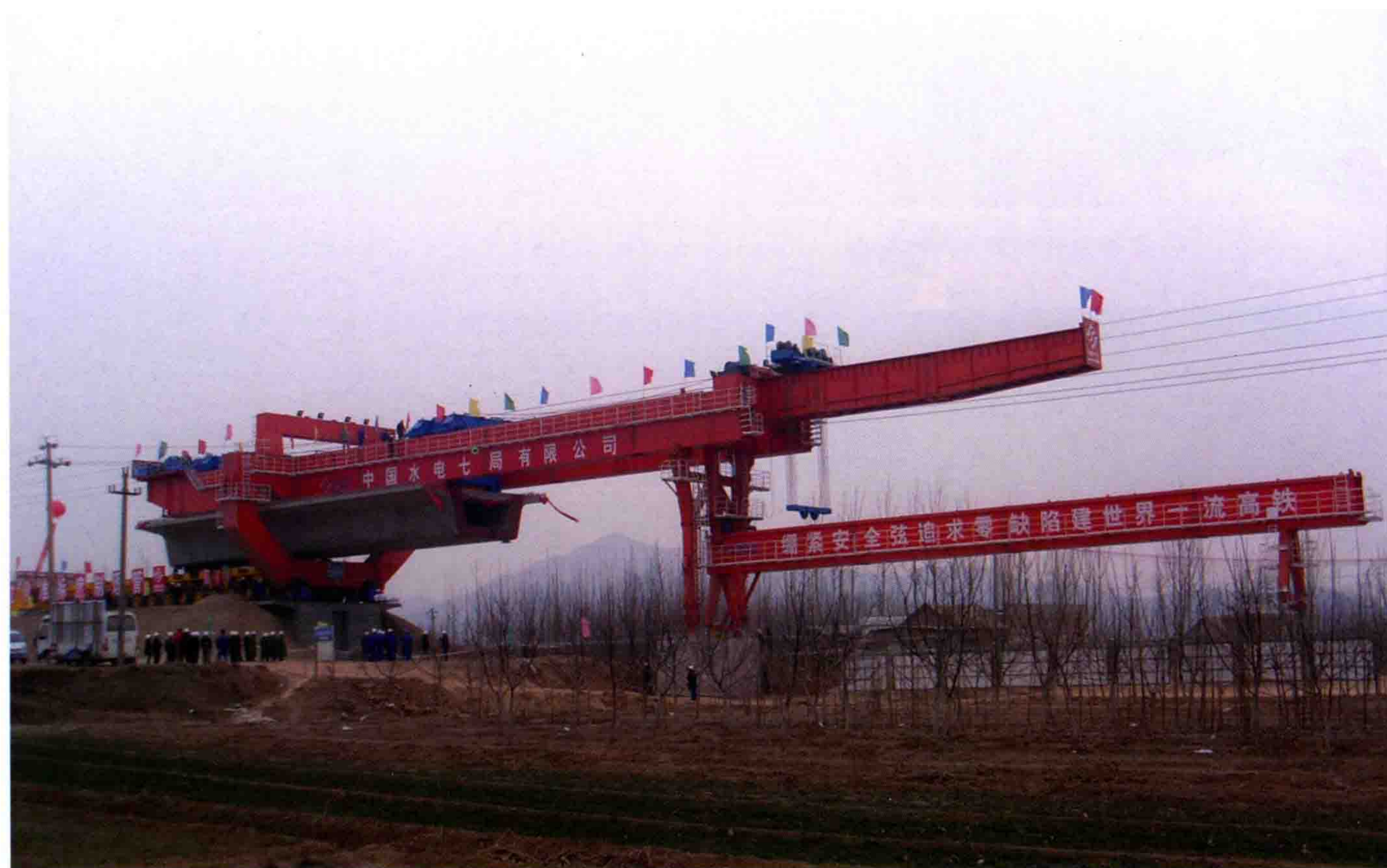
首孔箱梁架设
