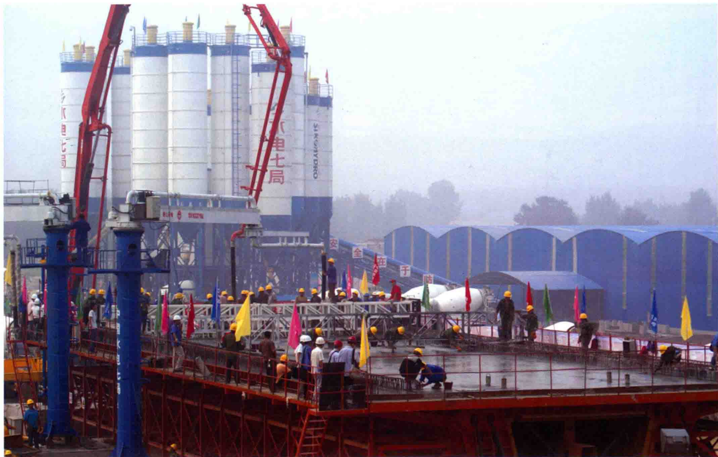
首孔箱梁浇筑
