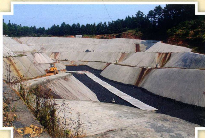
新建的锦屏县城垃圾填埋场
