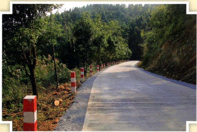
全州通村水泥路示范路——平略镇平整通村水泥路
