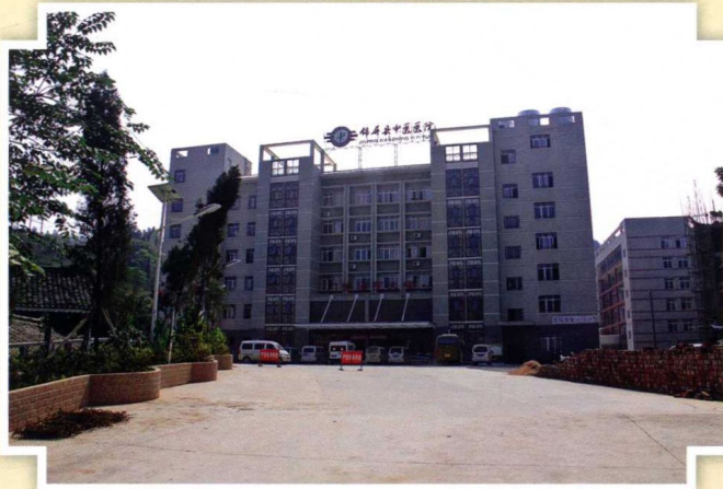
新建的锦屏县中医院门诊大楼
