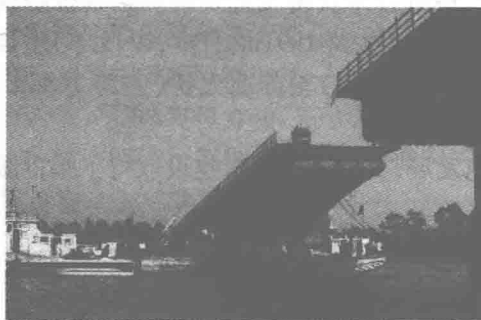
图 1-2 超限超载运输引起的桥梁垮塌事故
