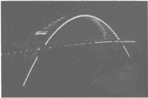
c)上海卢浦大桥
