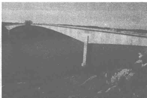
d) 挪威Stolmasundet连续刚架桥
