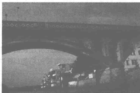
图 1-3 船只碰撞对桥梁的破坏
