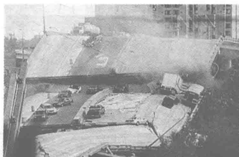
b)美国明尼苏达州一座桥梁坍塌
