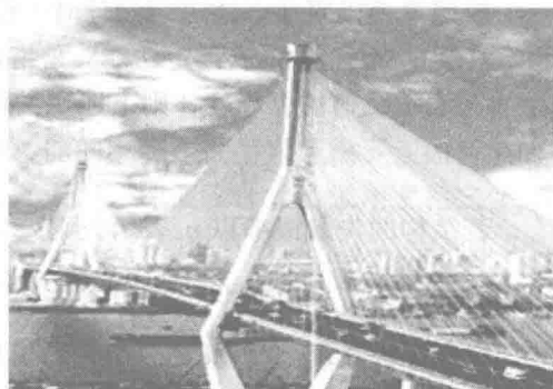
图 1.1 上海杨浦大桥
