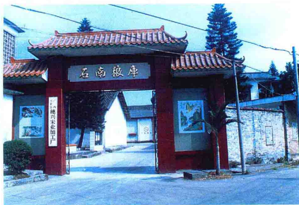
兴业县石南粮库
