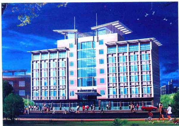
二00五年建成的兴业县粮食局办公大楼。
