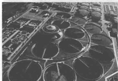
◆污水处理厂布满了大大小小的污水处 理池
