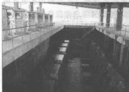
◆污水先经过格栅间除去较大的固体物
