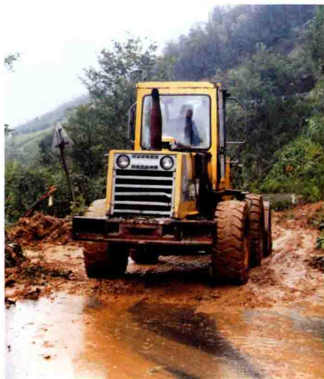
▼ 寺马线公路塌方抢修 (房立平供稿)
