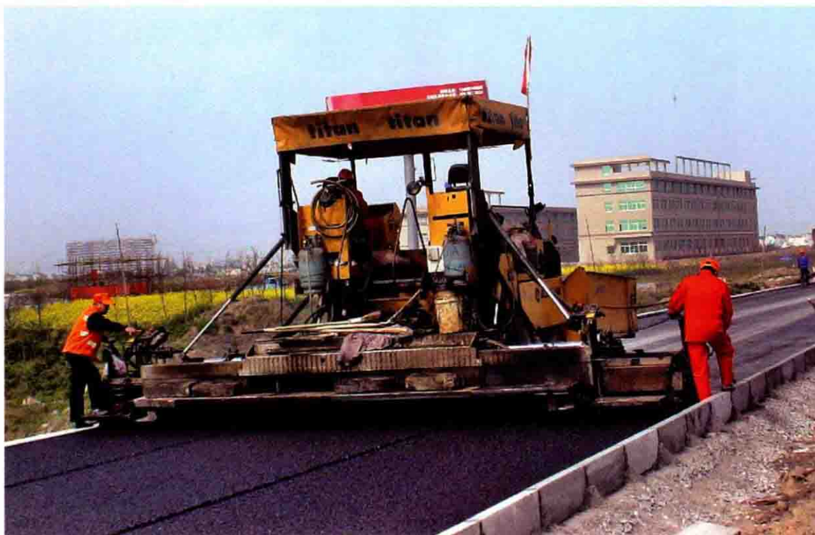
▼ 中横线道路施工 (干啸洪供稿)
