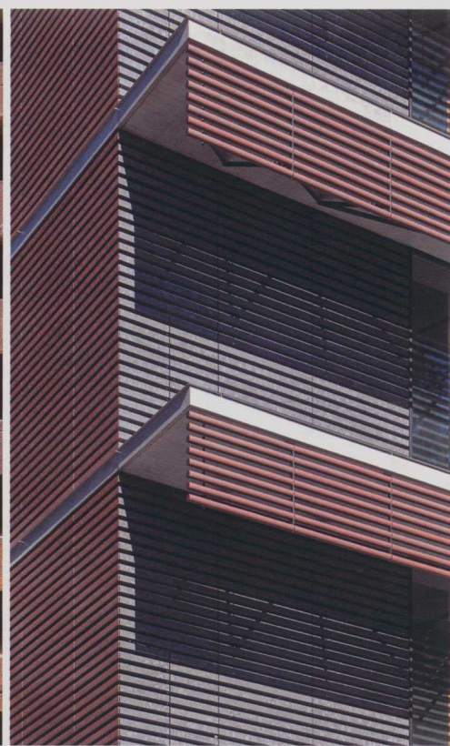
红陶百叶窗板由直径90 mm，长2000 mm的圆柱体组成
