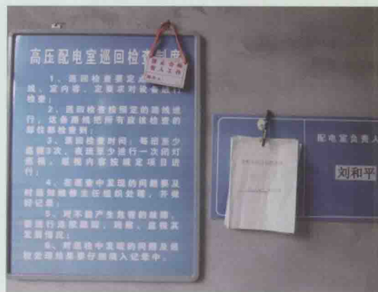
● 高压配电室管理制度
