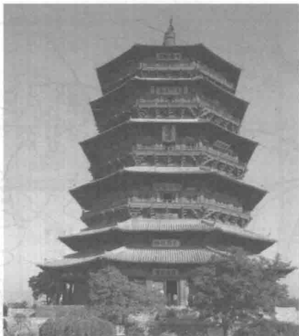
图 1-10 山西应县木塔
