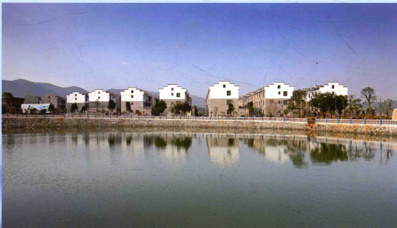
吉水县中村移民安置点
