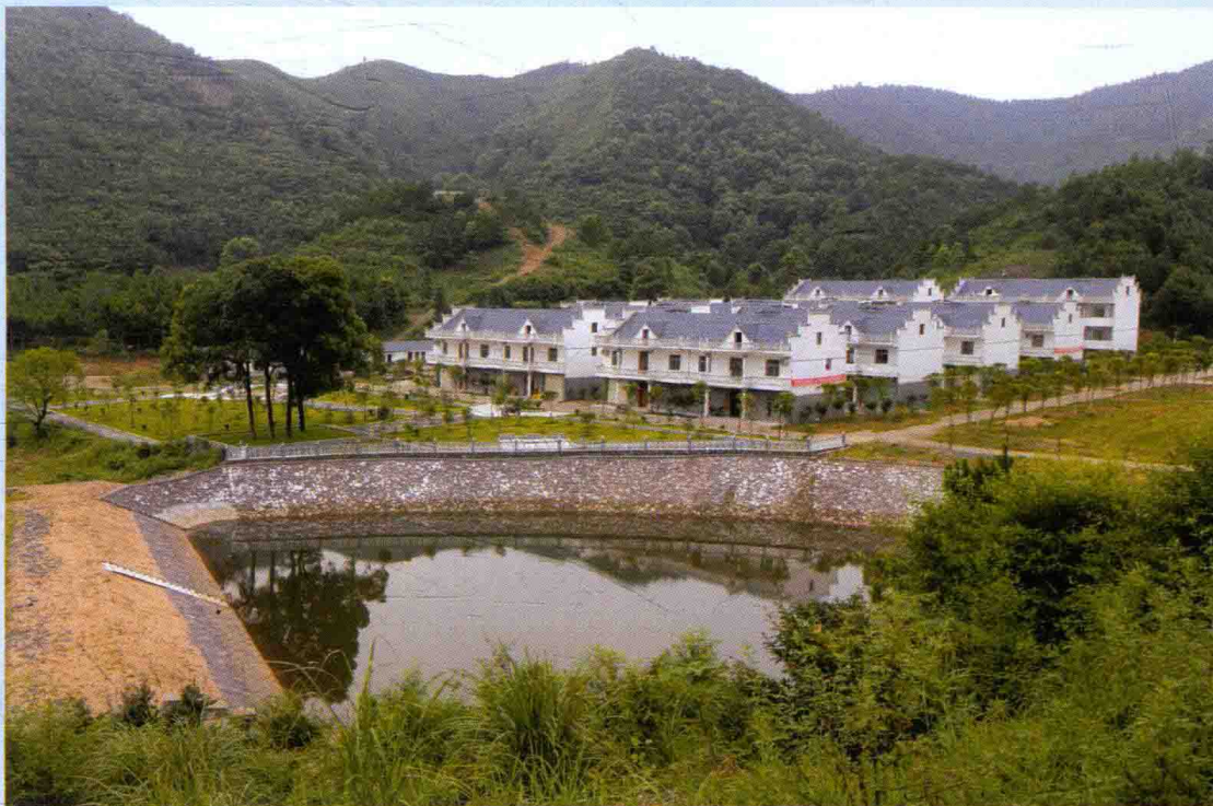
峡江县万台移民安置点
