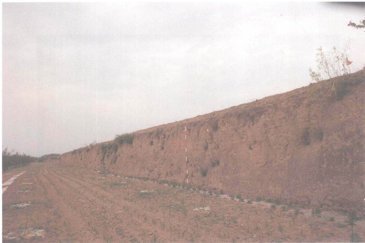
陕西合阳县魏长城河西坡村长城断点2西93米处墙体延伸情况
