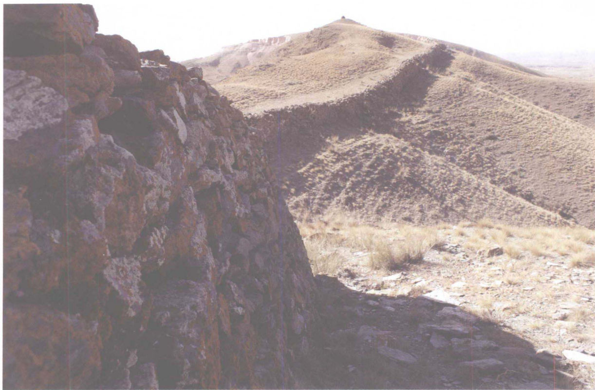
内蒙古固阳秦长城葛家边墙长城1段墙体及烽燧远眺（东—西拍摄）
