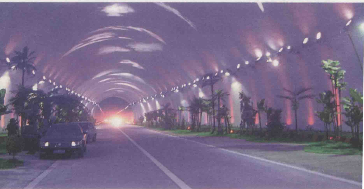
○ 秦岭 18 公里长的亚洲第一隧道
