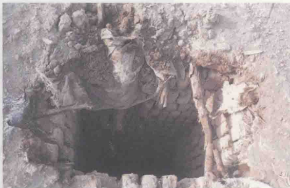
土坯加固竖井(西向东)
