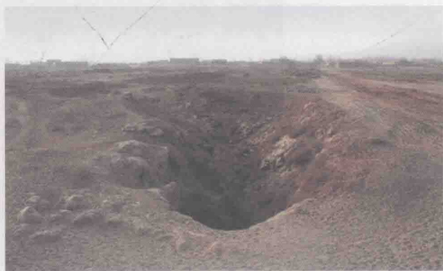
出水口现状(北向南)
