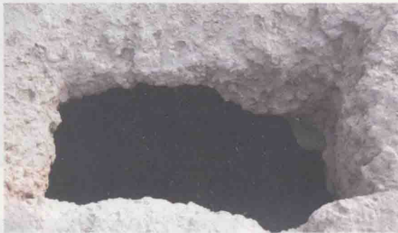
出水口(南向北)
