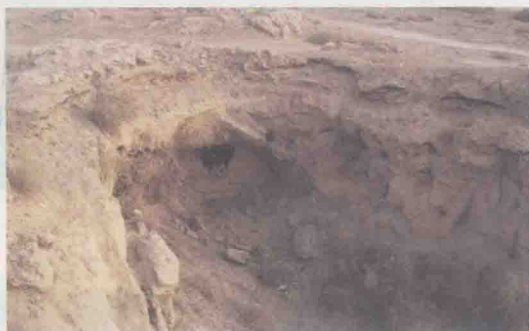
出水口(南向北)
