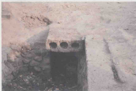
出水口(南向北)
