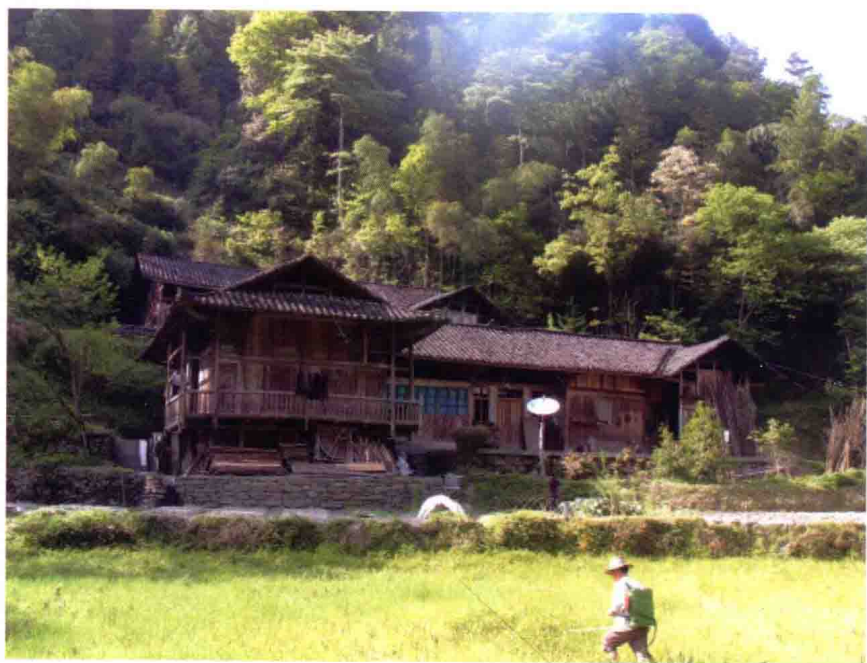
咸丰县高乐山镇农家界村钥匙头吊脚楼，通常钥匙头吊脚楼吊东不吊西，以求不遮挡西面阳光。（秦兴武拍摄）
