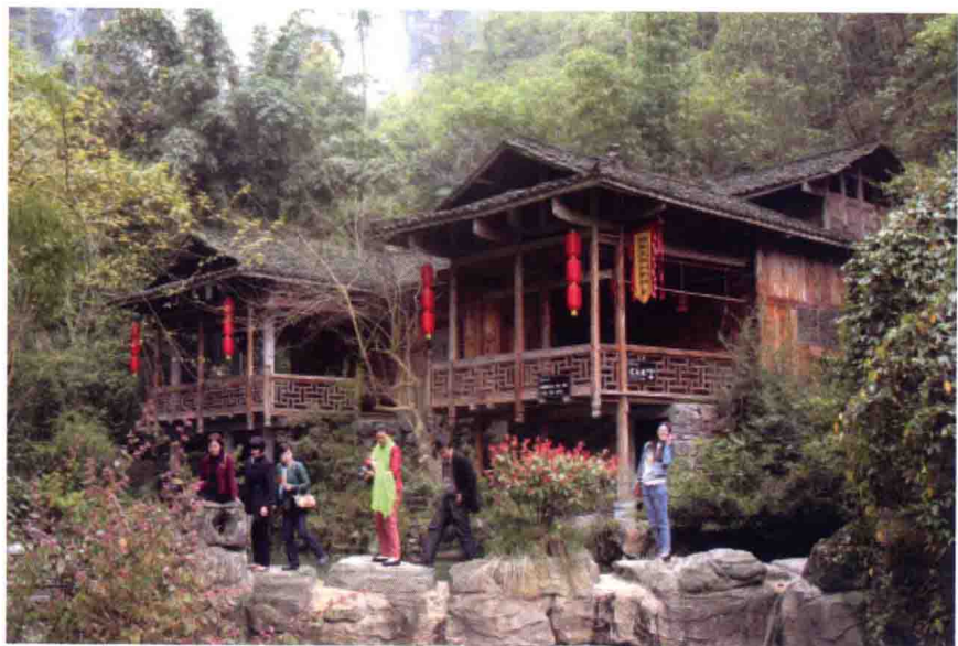
咸丰县朝阳寺镇黄虎坪撮箕口吊脚楼，坐落在幽静溪畔山涧旁，精纯之美映入眼帘，犹如一个守望故乡的老者，引来无数的游客驻足观瞻、嬉戏玩耍。（刘明建拍摄）
