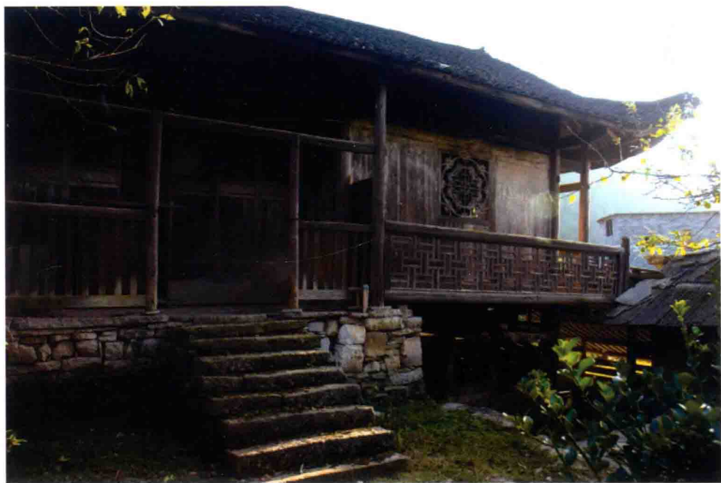
无人居住的古朴吊脚楼——咸丰县高乐山镇梅坪村水井坎吊脚楼，优雅轻盈，楚楚动人。（秦兴武拍摄）
