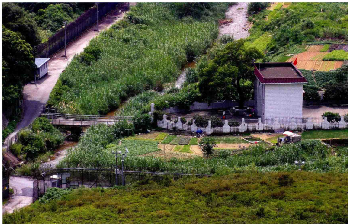
遠望橫跨深圳河上游的長命橋。橋右側為內地邊防檢查站，橋左側小屋為香港警崗。蓮麻坑河在圖中左下方匯入深圳河。（攝於 2011 年 7 月）
