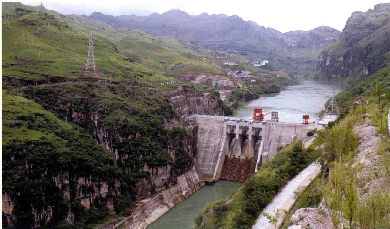
北盘江马马崖一级水电站重力坝（坝高 109m）
