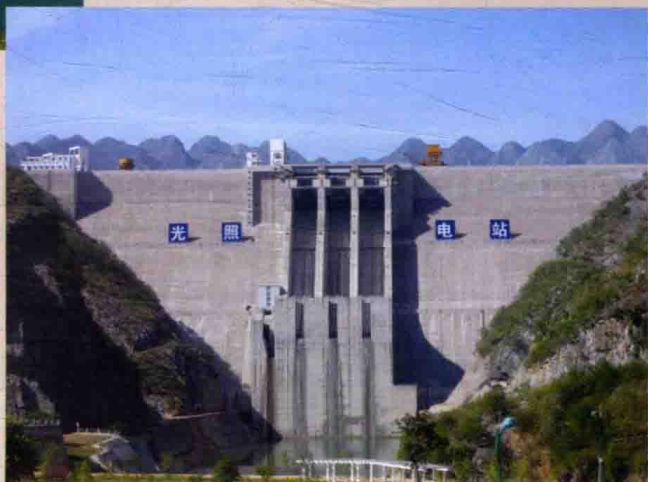
光照碾压混凝土重力坝（高 200.5m）
