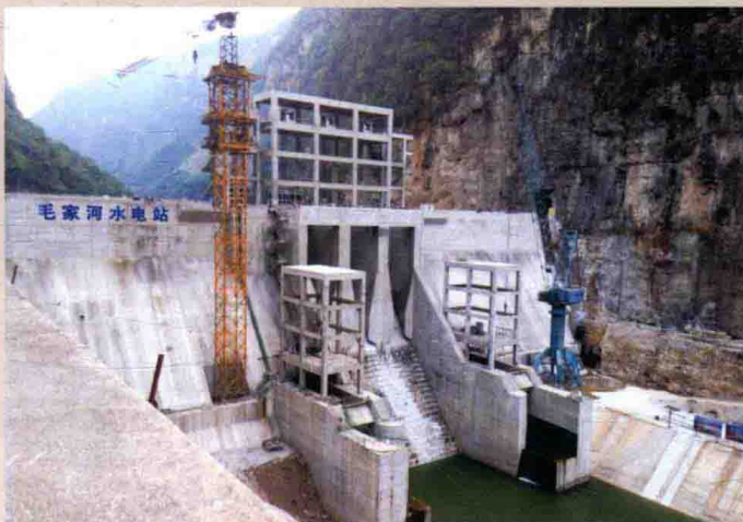
北盘江毛家河水电站重力坝（坝高 75m）
