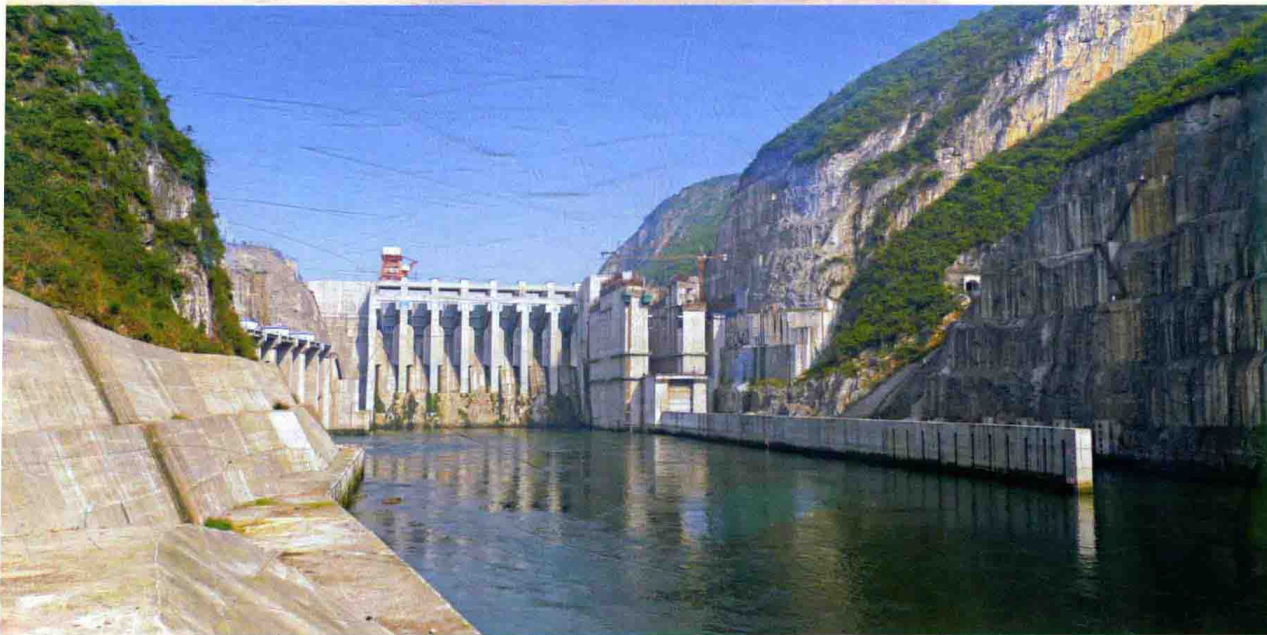
乌江思林水电站重力坝（坝高 124m）
