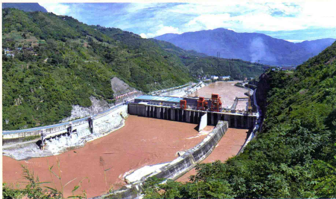
四川大渡河枕头坝一级水电站闸坝（坝高 86.5m）
