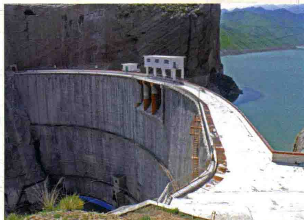
新疆石门子水电站拱坝（坝高 109m）
