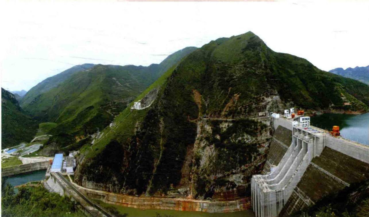
光照水电站枢纽建筑物由碾压混凝土坝、坝身泄洪系统、右岸引水系统及地面厂房等组成
