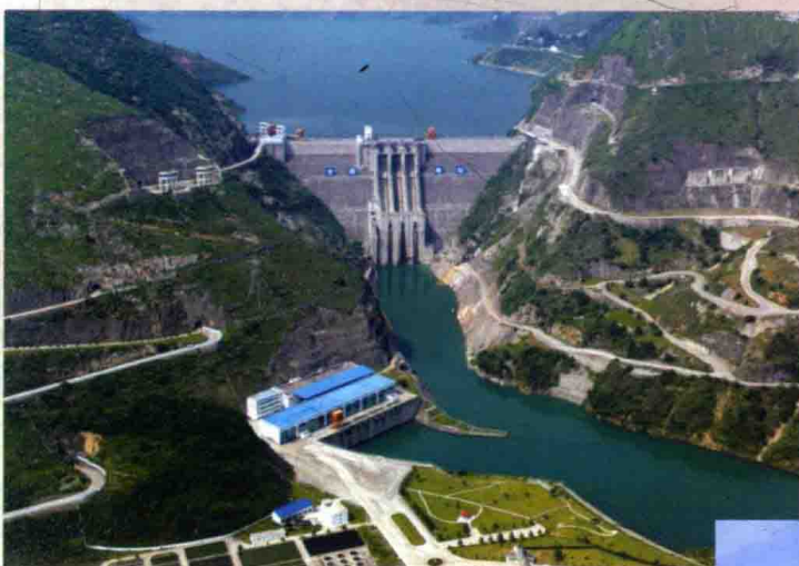
北盘江光照水电站枢纽全貌
