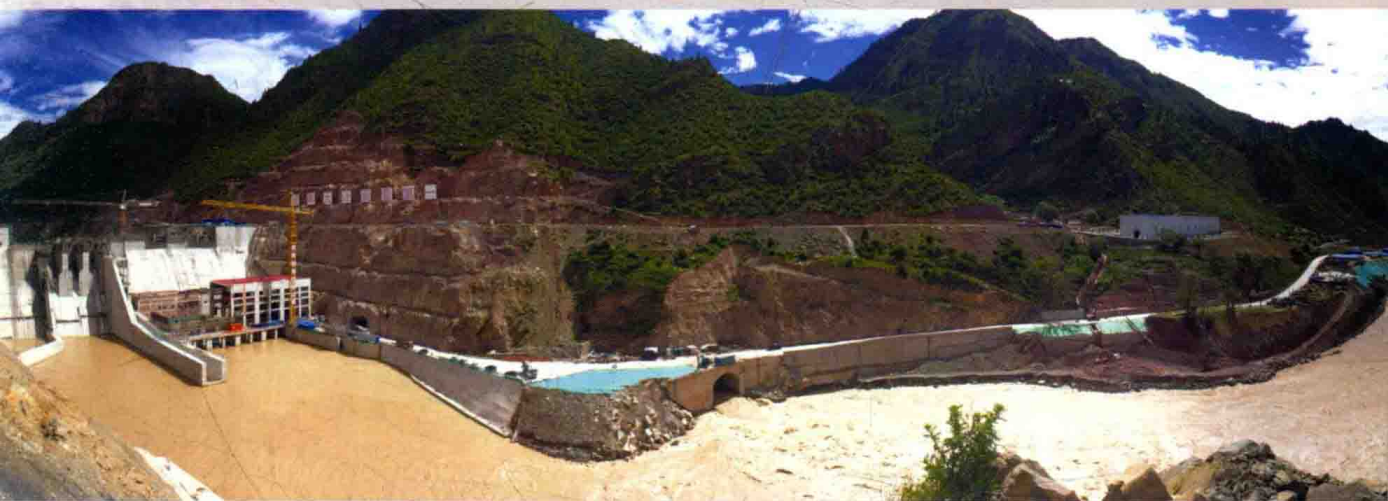
果多水电站重力坝（坝高 93m）
