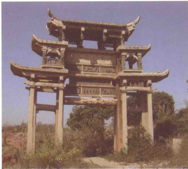
泉州东门外清代牌坊
