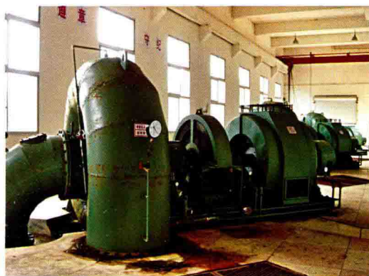
双溪水电站的卧式水轮发电机组
