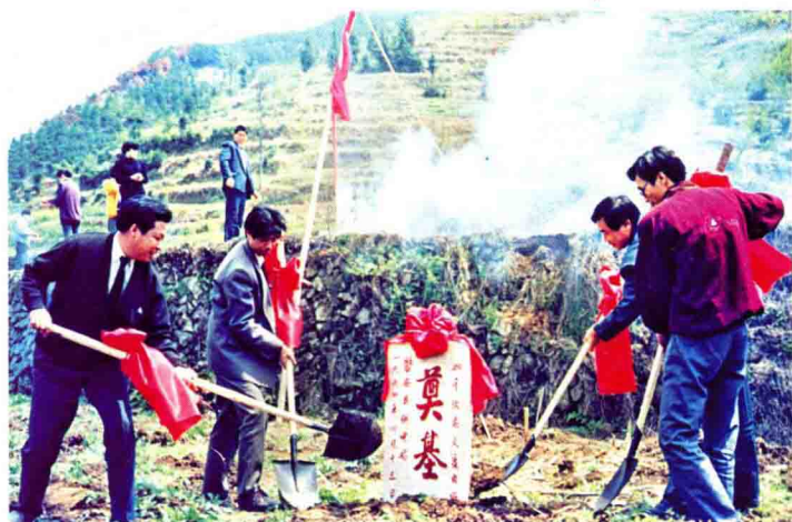
1994年10月28日, 磐安县人大主任孔宝泉(右二)、副县长蔡志成(左二)参加首座110千伏磐安变电所奠基仪式
