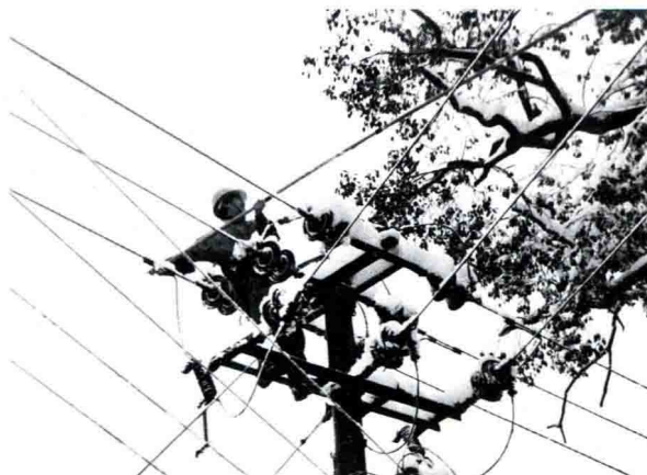
2004年12月,磐安县供电局职工冒雪抢修10千伏农村线路
