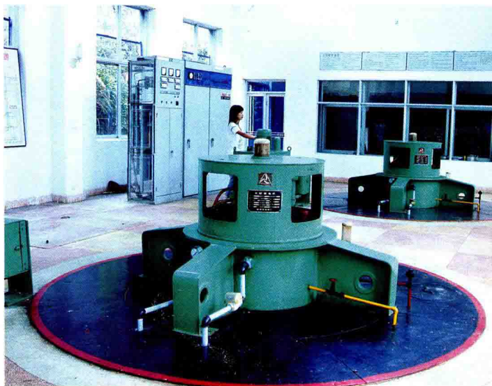
姜山头水电站的立式水轮发电机组
