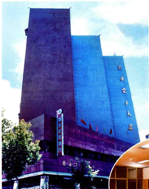
磐安县供电局电力调度 综合大楼
