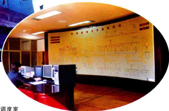
磐安县电力调度室
