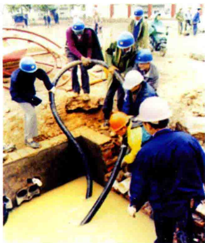
1998 年整改城网时, 电力职工在 县城城中路敷设地下电缆
