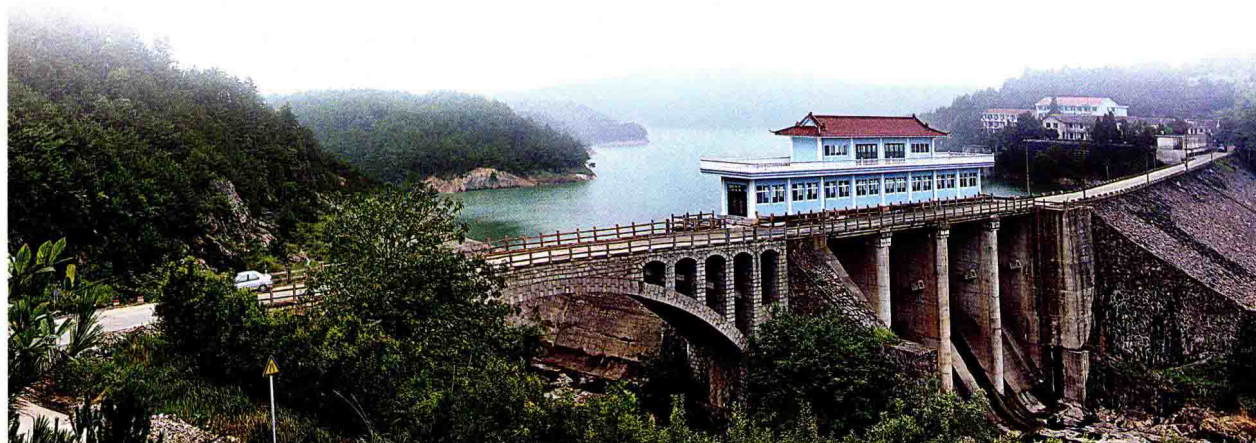
五丈岩一级水电站拦河大坝
