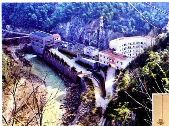
三曲里水电站
