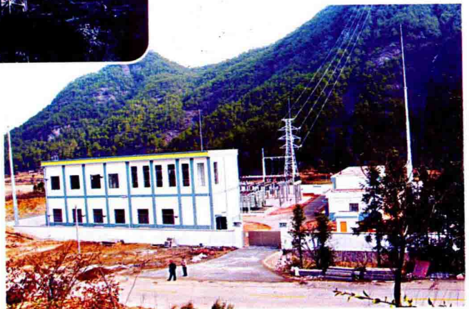
新建的 110 千伏冷水变电所
