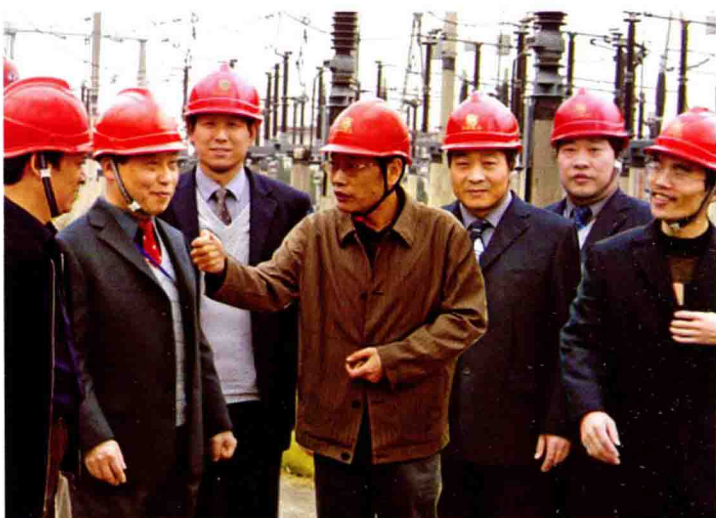
2005年11月, 金华电业局局长程极盛(中)在磐安县供电局领导班子陪同下到建设中的110千伏冷水变电所检查工作
