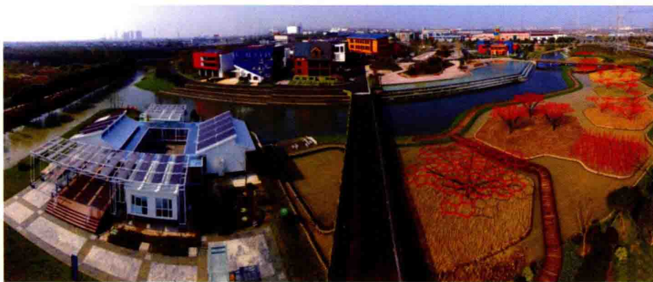
图 2-4 江苏省绿色建筑博览园航拍 (来源：高岷摄)
