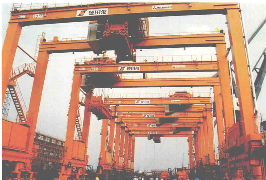
一期工程码头
