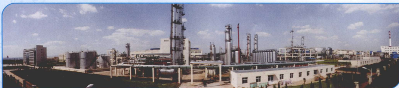
以煤为原料二甲醚项目——20万吨甲醇、10万吨二甲醚项目
