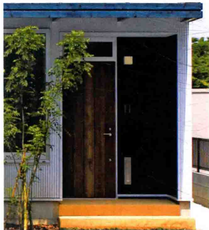
成品的隔热门 + 铺装木板
