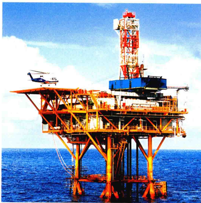
中海油南海西部石油公司海上采油平台（宋成功 摄）
