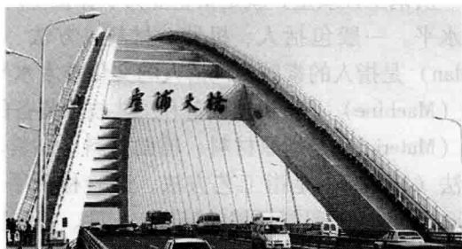
图 1-2 上海卢浦大桥
