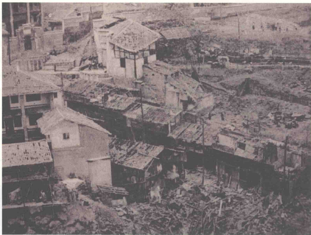
在重庆一个较为富裕的住宅区：有些房屋仍然屹立着，而其他房屋则变成了一片废墟
