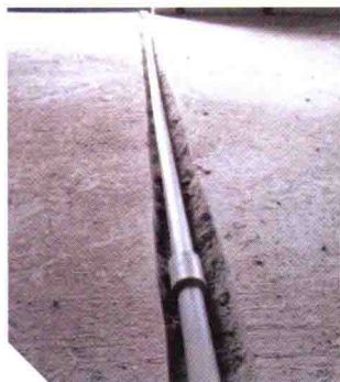
04 配管、穿线；固定安装
