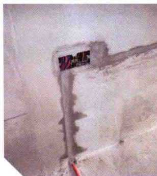
08 全面检查，封闭管线槽
