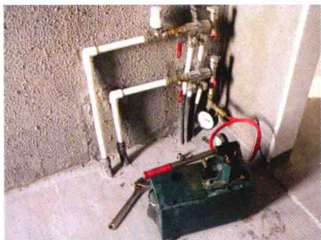
图 1-8 给水管打压
