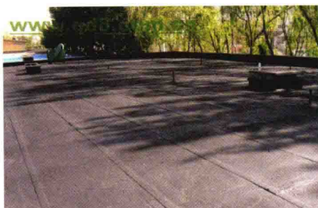
图 1-20 查看屋顶防水屋
