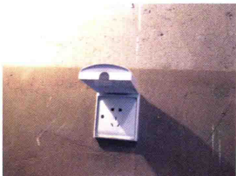
图 1-14 卫生间插座防水盖板
