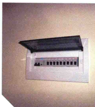
16 安装空气开关
