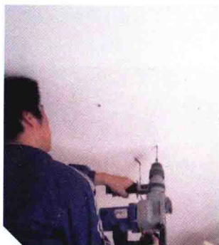
13 安装基础固定预埋件
