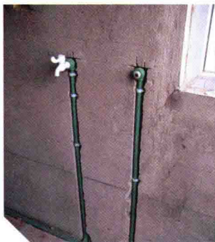
05 安装临时水电设备
