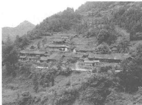
图 1.3 石柱县金岭乡银杏村传统民居
