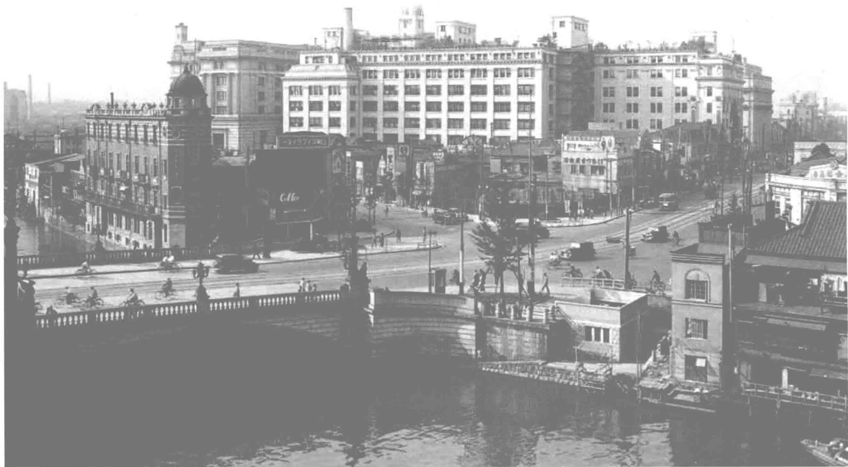
1935年時的東京日本橋一景。位於東京都橫跨日本橋川的橋樑從德川幕府時期1603年木橋興建，其後歷經19次改建，終於在1911年整建為今日的雙拱石橋。在建造此橋時明治天皇希望能將此橋建造成能與巴黎亞歷山大三世橋一般足以代表日本國力、千年不壞的雄偉大橋。在橋中央石墩上，分別是手扶車輪的獅子與背負翅膀的麒麟銅雕，代表日本的道路樞紐與飛向未來的首都，同時橋中央也是日本全國道路的起點。圖片後方為建築師辰野金吾教授設計的日本銀行總行大樓。
