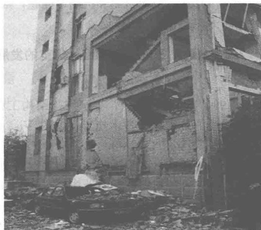
图 1.2-3 墙体倒塌
