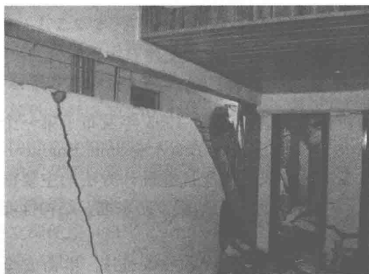
图 1.2-2 填充墙倾倒
