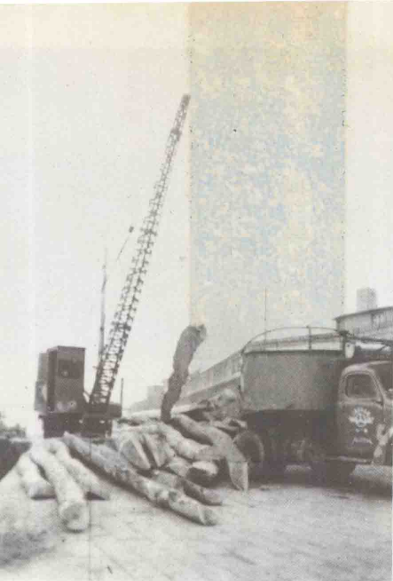
城关码头吊杆
