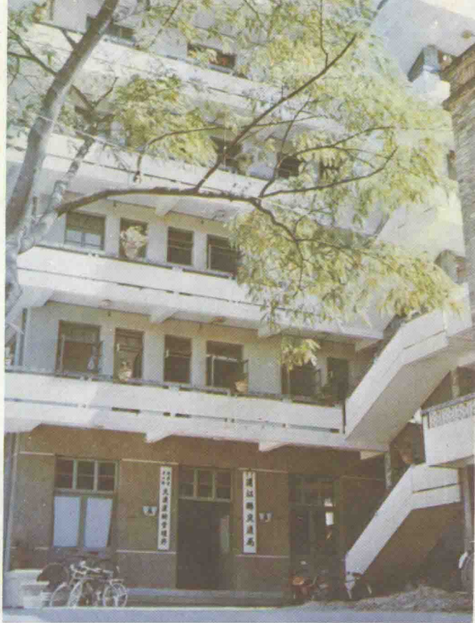
连江县交通局办公大楼
