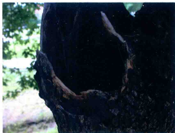
3 树木养护不好造成的树洞
